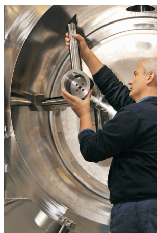
Демонтаж лопаток мешалки
